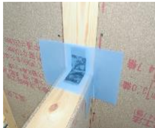
ベランダ部施工
