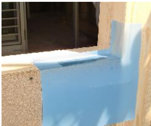
コーナー部施工
